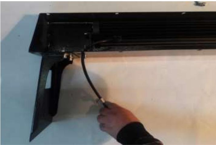
2. Устанавливаем светодиодную балку (или балки) в короб. Крепим балку (балки) к коробу на родные кронштейны. Выводим электропроводку через технологический проём.
