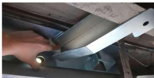
3. Закрепите болтом М8 лонжероны усилителя с опорной балкой.
